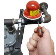
14. Abra el paso de gas en la válvula de entrada del medidor. No use llave para tubos.
