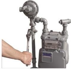
2. Cierre el gas en la válvula de entrada del medidor. No use una llave para tubos.
