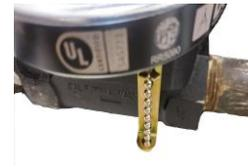
10. Usando la cadena de nivel como guía, confirme que la válvula este nivelada.
