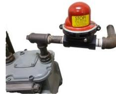
9. Instale el empaque de la unión y tuberías nuevas desde el edificio hasta el medidor.
