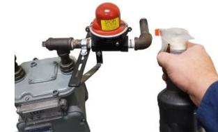
16. Aplique pintura a todas las tuberías nuevas para evitar la oxidación.
